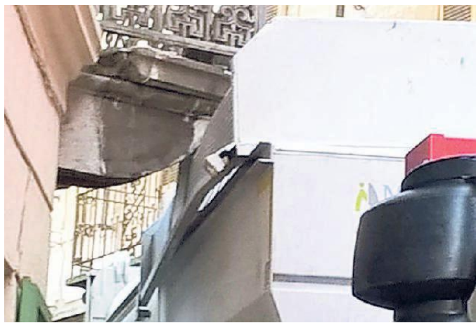
Il camion ha demolito il balcone in via Cuniberti
