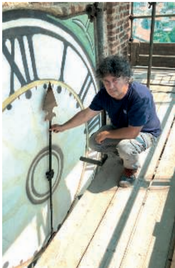
MORETTA - C'è stato qualche ritardo e l'impalcatura del campanile della Crociata è stata rimossa solamente la scorsa settimana. Ecco da vicino l'orologio del '700 ritrovato sotto a quello che si vedeva di fine '800: a fianco, Fabio Garnero il restauratore che l'ha fatto rivivere.
