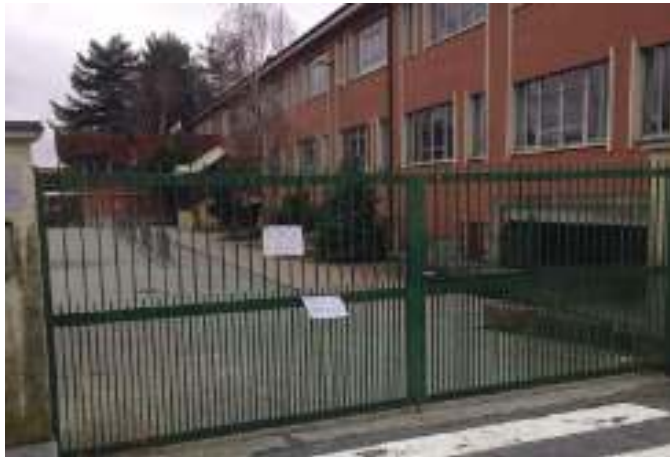
LA SCUOLA di Caluso sarà interessata da un'opera che prevede la realizzazione della nuova controsoffittatura dell'edificio
