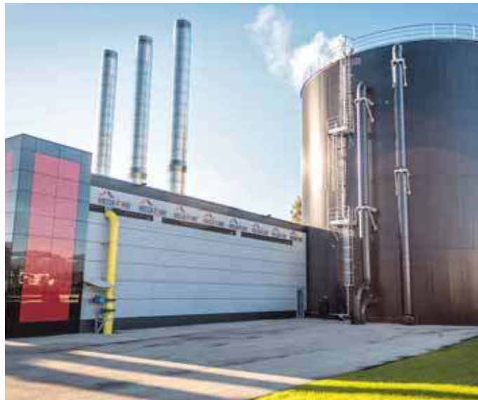
La nuova centrale del teleriscaldamento in zona Agc.
